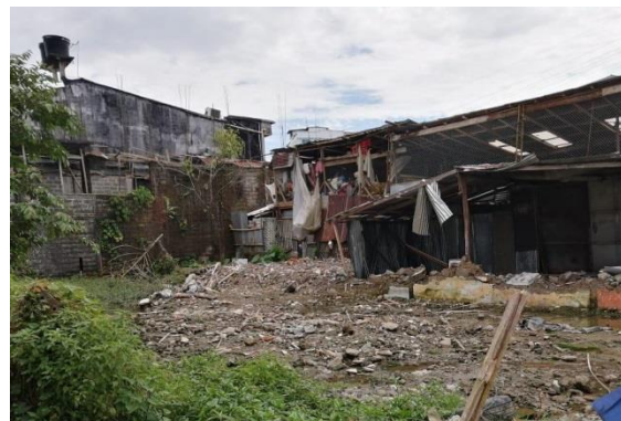
Fotografía 2. Vista actual del predio Quibdó
