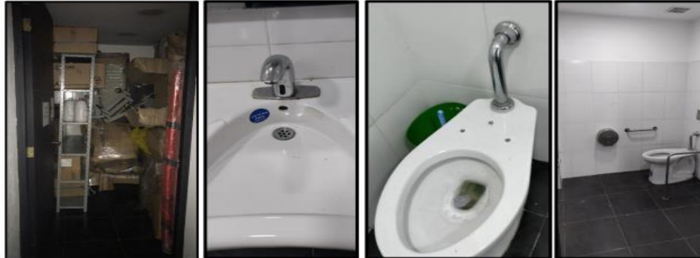
Foto 13, 14, 15 y 16. Estado del baño de discapacitados
