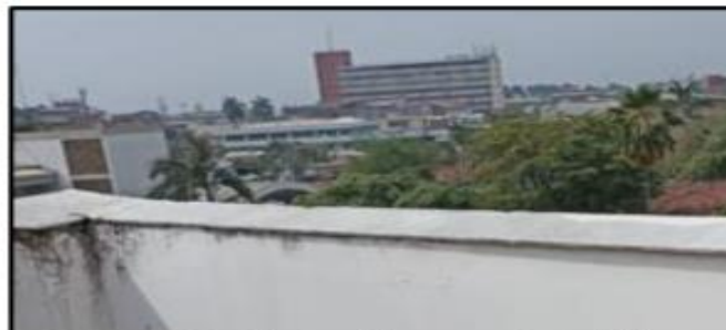
Foto 19. Instalación de lagrimal de muro perimetral de la terraza.
