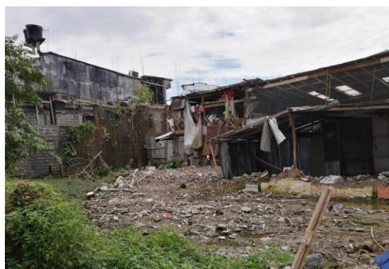
Fotografía 2. Vista actual del predio Quibdó
