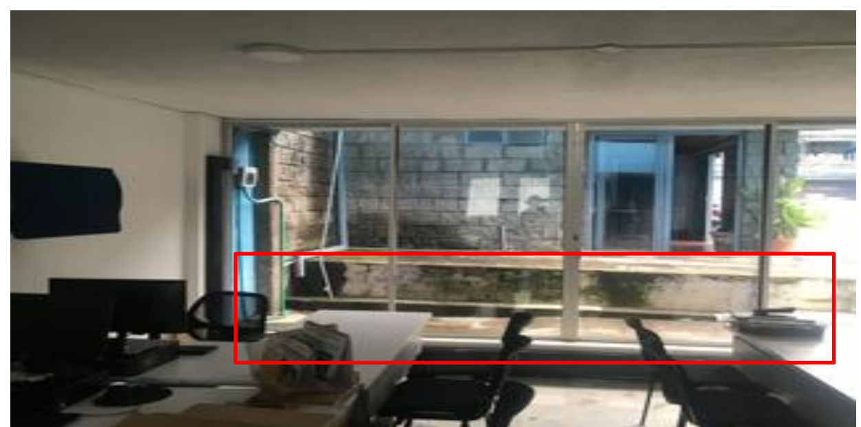
No. 25 Oficina de direccion de Investigacion y Vigilancia - Ministerio de Trabajo - Humedad sobre placa piso y muros.
