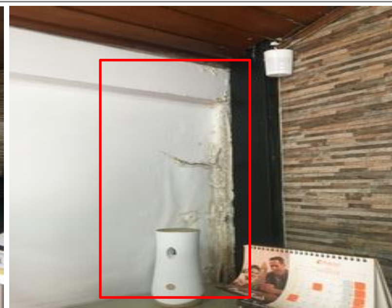
No.8 Humedad interna Oficina de Direccion del Ministerio de Trabajo
