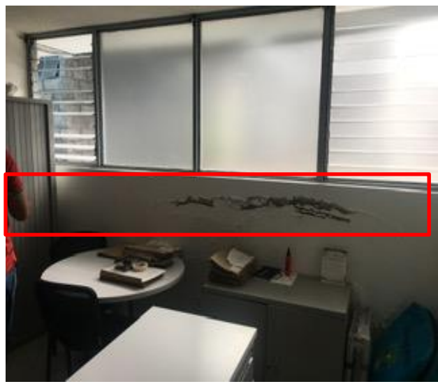
No. 21 Oficina de coordinacion y Vigilancia Ministerio de Trabajo con humeda sobre muros.
