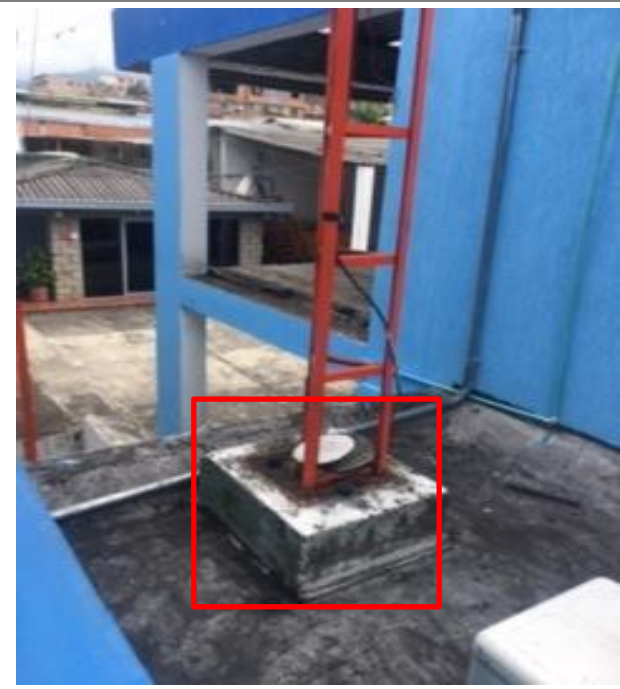
No. 29. Antena de comunicación - Direccion de Riesgos - sostenida con tensores sobre puestos metalicos y estructura metalica sobre puesta anclada en pedestal de concreto sobre placa aerea.
