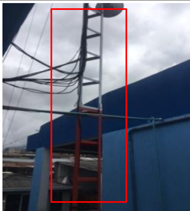
No. 29. Antena de comunicación - Direccion de Riesgos - sostenida con tensores sobre puestos metalicos y estructura metalica sobre puesta anclada en pedestal de concreto sobre placa aerea.
