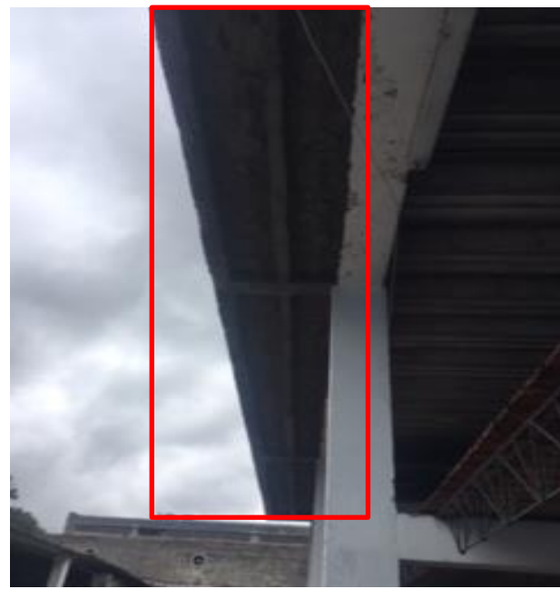
No.11 Desprendimiento de concreto en viga canal de estructura de la bodega de alimentos de la Dirección de Riego Departamental.
