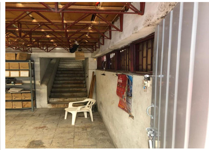
No. 36 Escalera de accesos a bodega de alimentos - Gestion de Riesgo - Escalera con fisuras Horizontales
