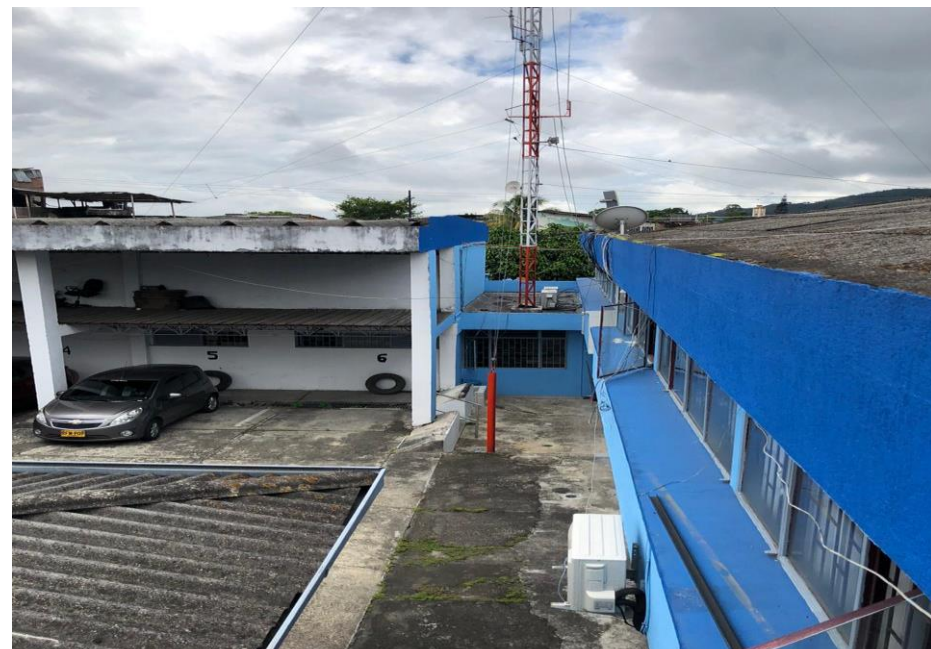
No. 43 Panorámica de cubiertas y viga canal
