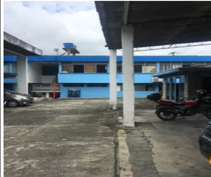
No.4 Parqueadero con placa contrapiso desnivelada y fisurada y columnas fisuradas
