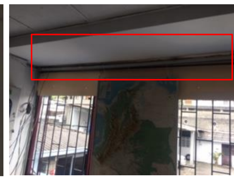
No. 26 oficina de Gestion de Riesgo con humeda y filtracion sobre muro y pegue viga canal.- Segundo Piso.
