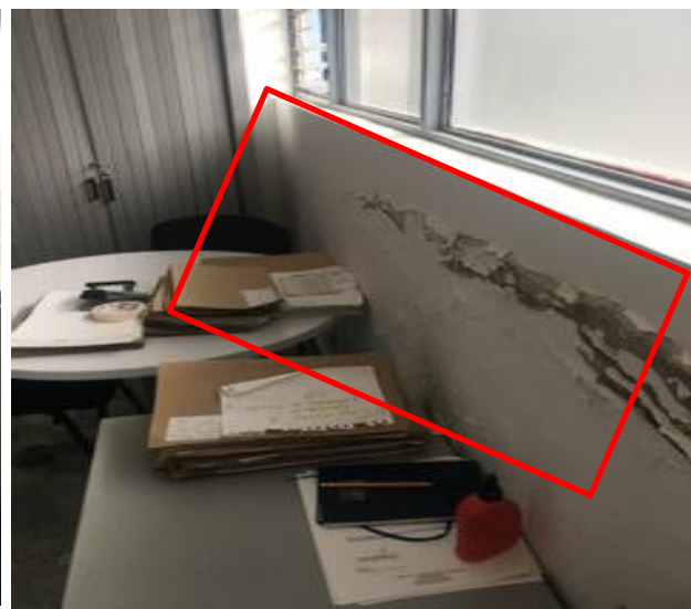
No. 21 Oficina de coordinacion y Vigilancia Ministerio de Trabajo con humeda sobre muros.
