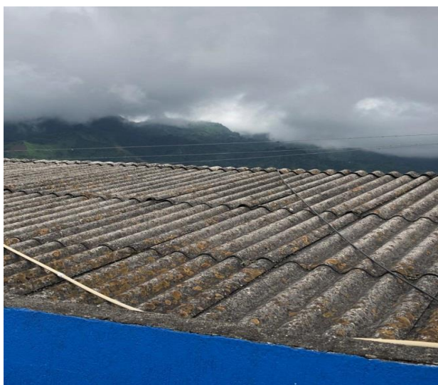
No. 41 Cubierta de las Estructuras en Asbesto cemento
