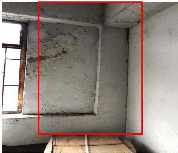
No. 39 Bodega de alimentos nive 2 con fisuras en los muros, columnas y vigas
