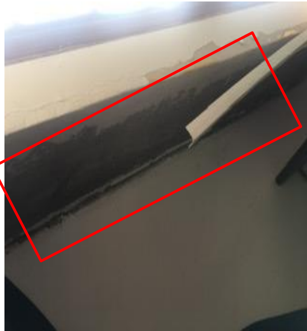
No. 27 Sala de radios - Segundo piso - Humedad y deterioro muros.
