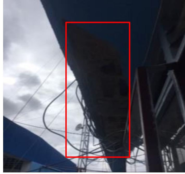
No. 28 Cara inferior viga canal con desprendimiento de concreto y aceros de refuerzo a la vista sueltos y oxidados.
