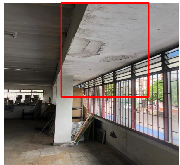
No. 37 Bodega de alimentos nive 2 con fisuras en los muros, columnas y vigas
