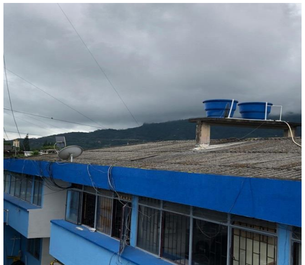
No. 41 Cubierta de las Estructuras en Asbesto cemento
