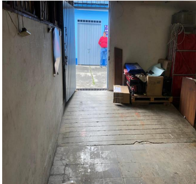
No. 35 Bodega de alimentos primer piso - gestion de riesgo - muros y columnas con fisuras verticales - piso con fisuras y grietas en los pegues.
