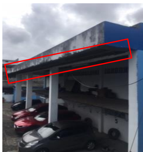
No.11 Desprendimiento de concreto en viga canal de estructura de la bodega de alimentos de la Dirección de Riego Departamental.
