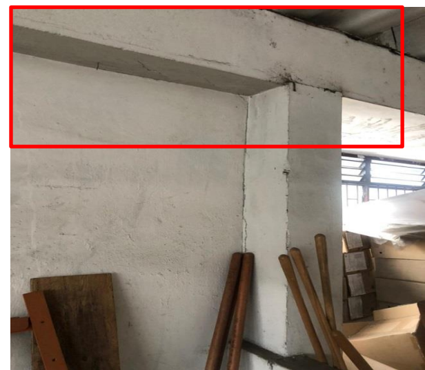
No. 39 Bodega de alimentos nive 2 con fisuras en los muros, columnas y vigas
