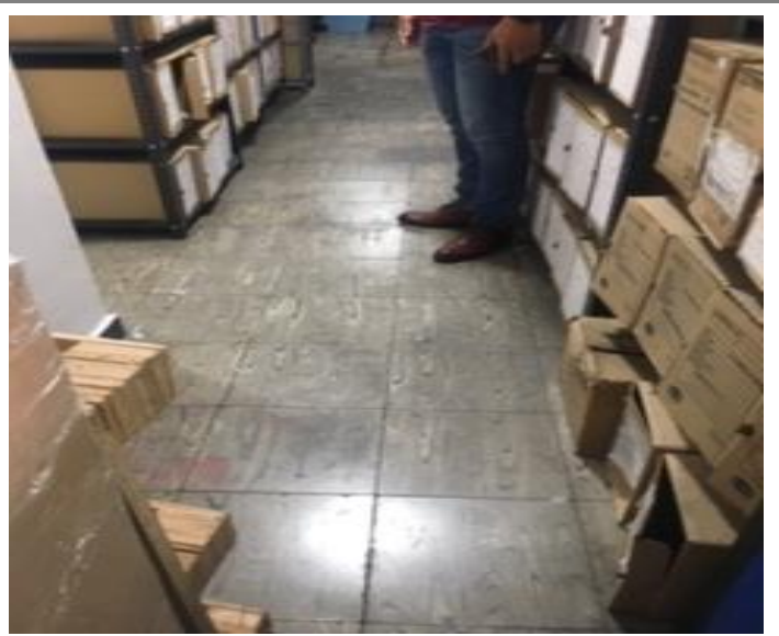
34 Archivo - Minsiterio d eTrabajo - Piso con fisuras y muros con humedad y fisuras
