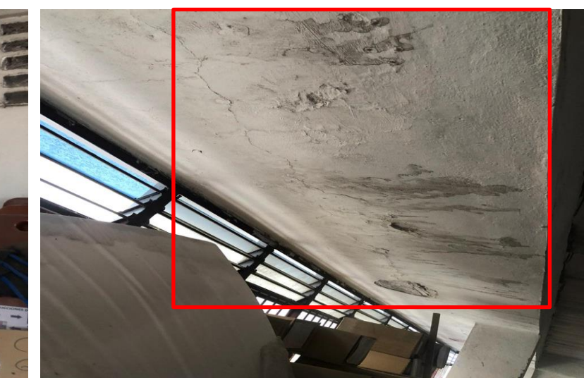
No. 40 Bodega de alimentos nive 2 con fisuras en los muros, columnas y vigas
