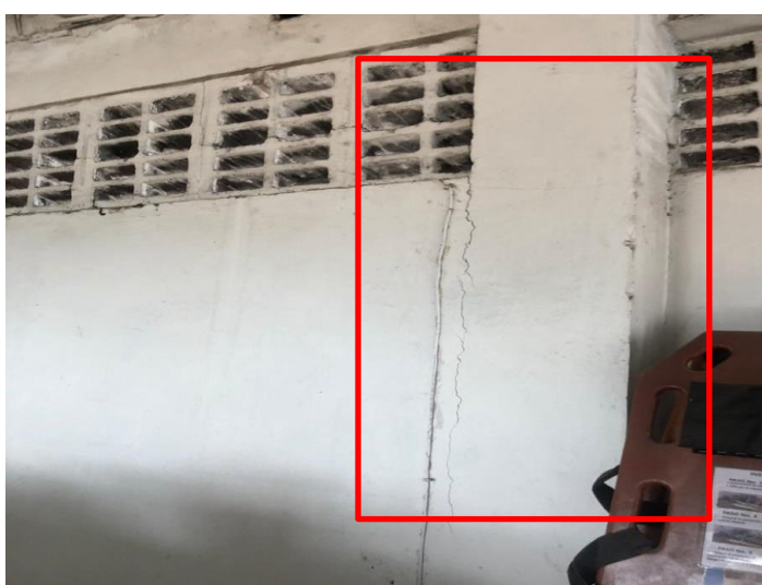
No. 40 Bodega de alimentos nive 2 con fisuras en los muros, columnas y vigas
