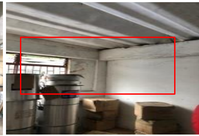
No. 38 Bodega de alimentos nive 2 con fisuras en los muros, columnas y vigas
