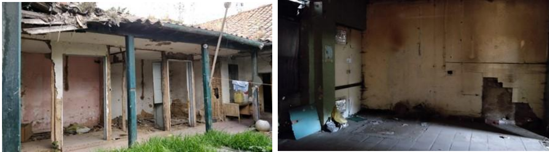
Estado actual de la edificación existente y establecida en los diseños su demolición y retiro
