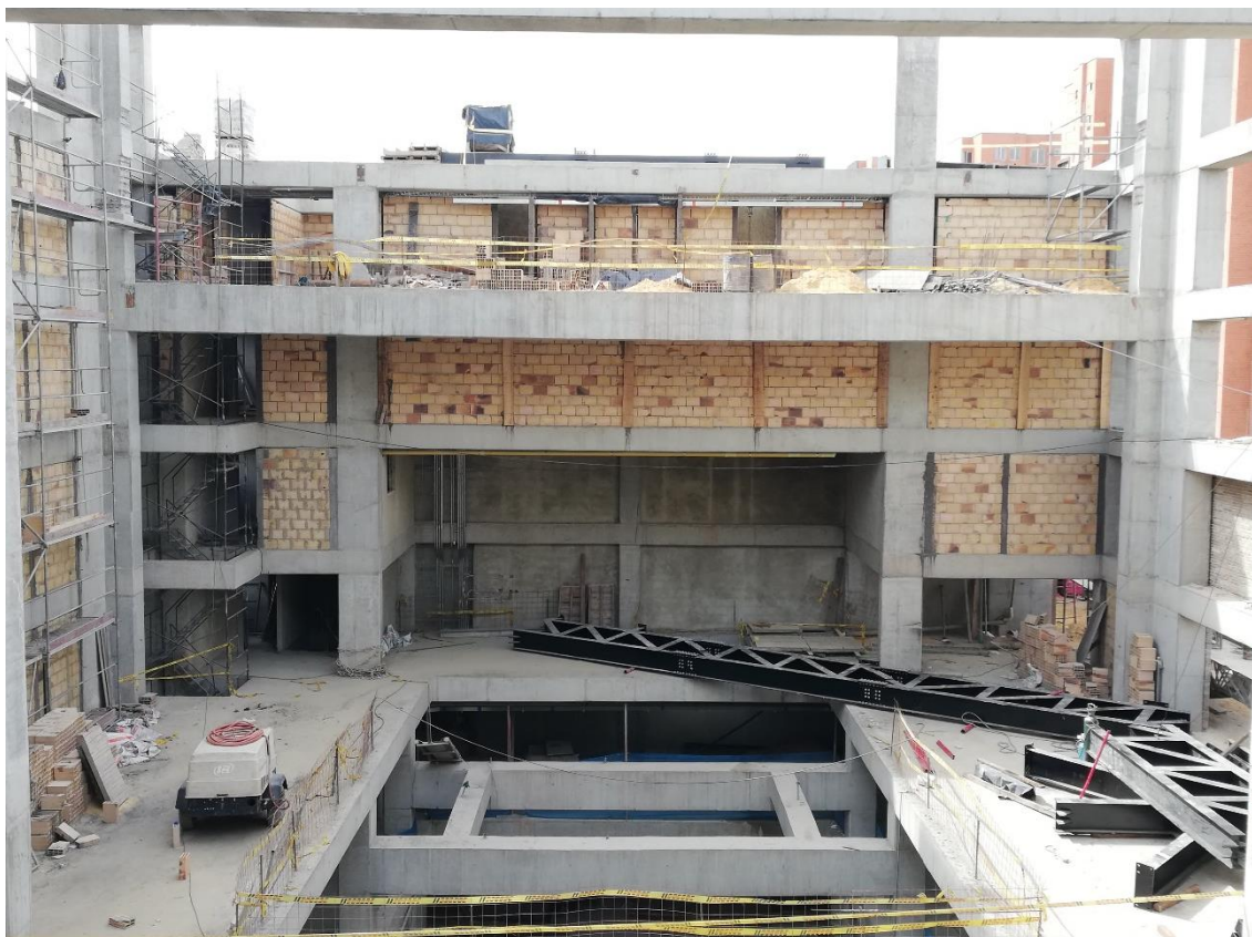
Imagen N° 8. Ensamble y posicionamiento de viga Warren Serie 500.
