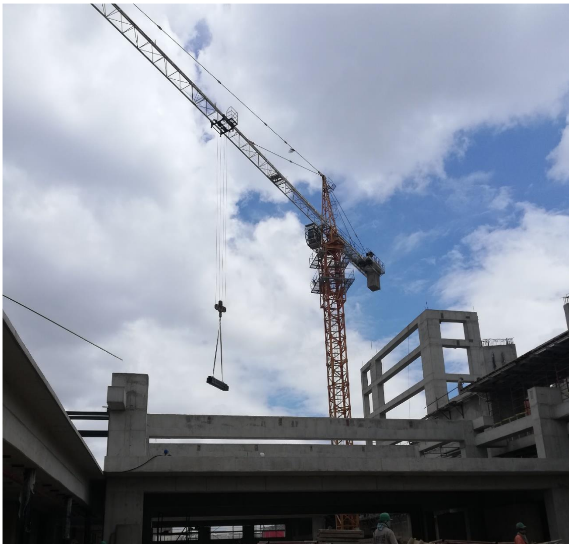
Imagen N° 7. Descarga de estructura metálica con torre grúa.
