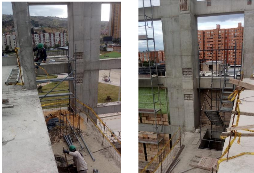
Imagen N° 10. Andamios para acceso a conexión soldada Viga Warren.
