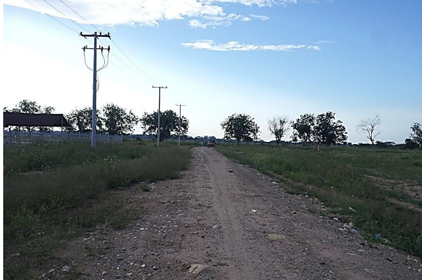
VIA DE ACCESO SIN PAVIMENTAR-VISTA DESDE EL NORTE
