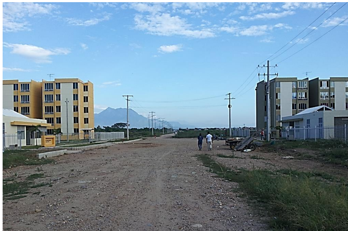
VIA DE ACCESO, CARRERA 27- VISTA DESDE EL SUR
