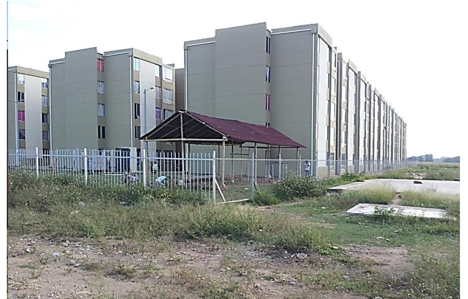
RELACIÓN PARQUE-ETAPA 1- LÍMITE MUY MARCADO POR EL CERRAMIENTO
