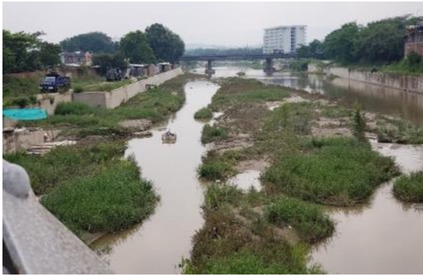
Fotografía tomada sobre el puente metálico de la carrera 5 hacia la carrera 2
