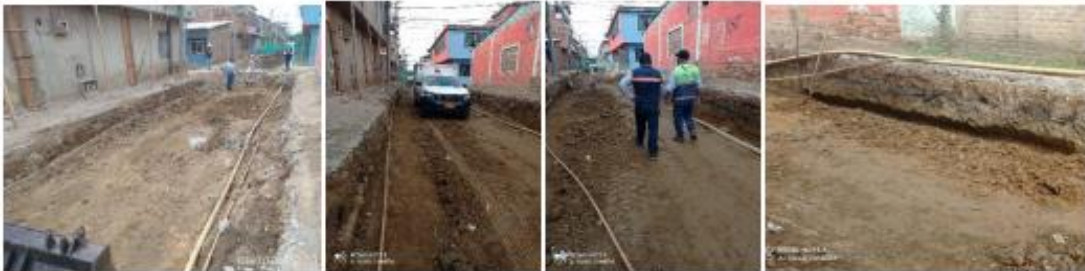
Tubería de Gas – Costado Derecho y Costado Izquierdo Calle 72 P – Fase 2
