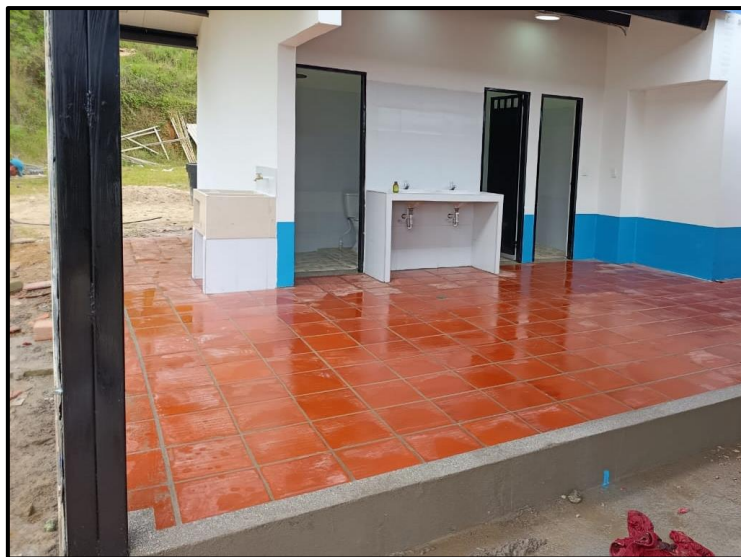
Ilustración 7 Batería sanitaria intervenida
