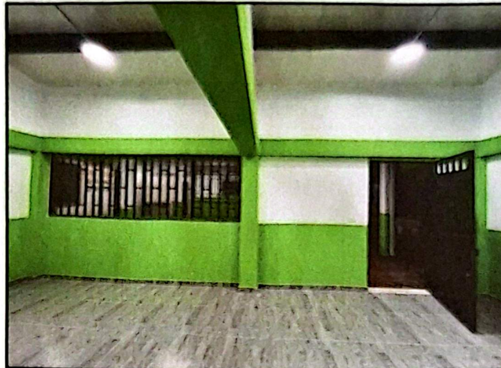
Ilustración 2 Instalación de carpintería metálica aula 1
