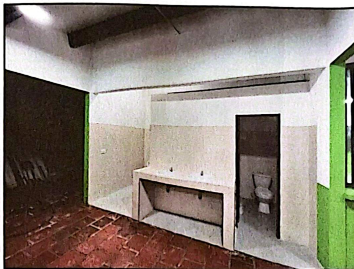
Ilustración 7 Bateria sanitaria intervenida
