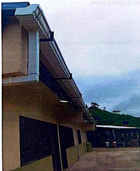
Ilustración 6 Fachada principal intervenida
