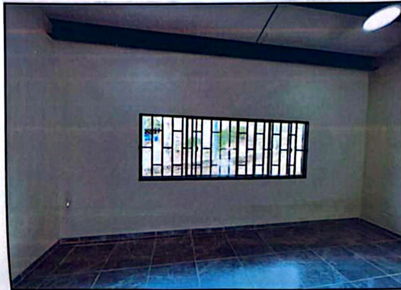
Ilustración 2 Instalación de carpintería metálica aula 1
