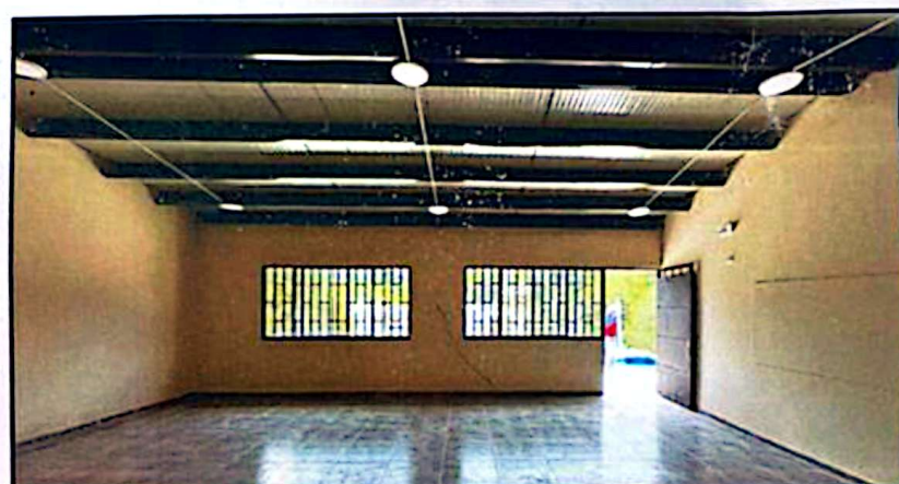
Ilustración 4 carpintería metálica del aula 2
