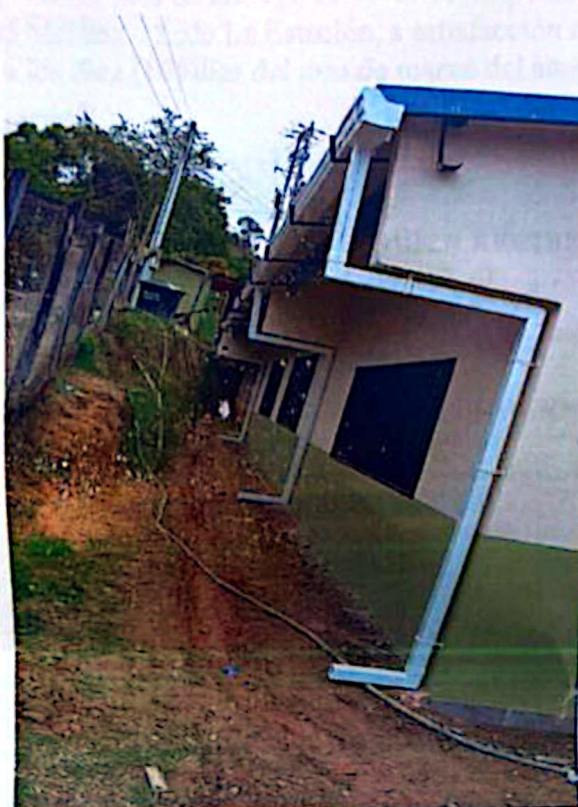
Ilustración 5 Fachada posterior sede intervenida
