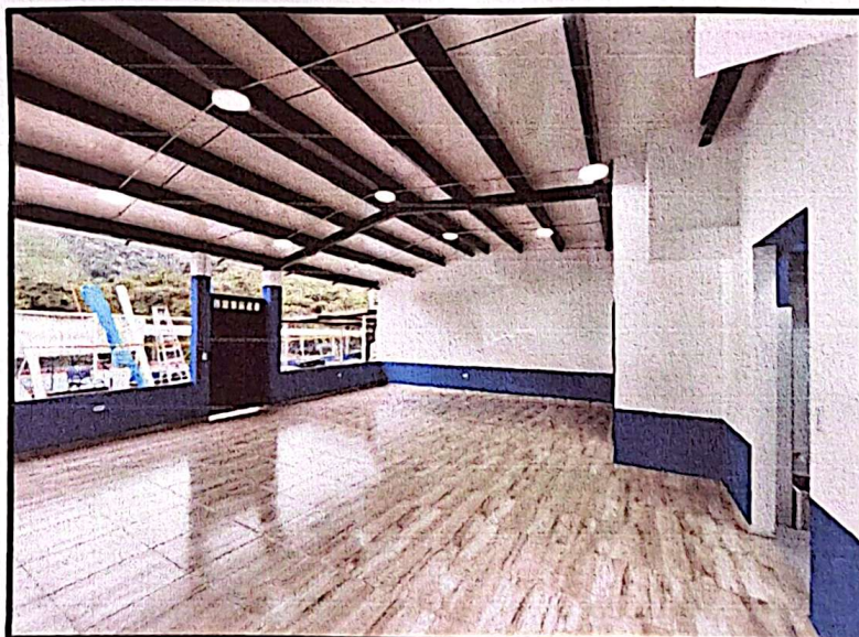
Ilustración 4 área de comedor intervenida
