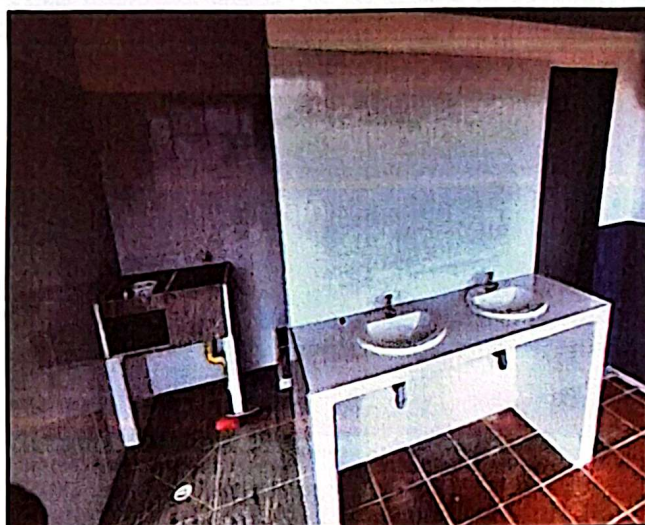
Ilustración 10 Bateria sanitaria y tanque prefabricado intervenidos
