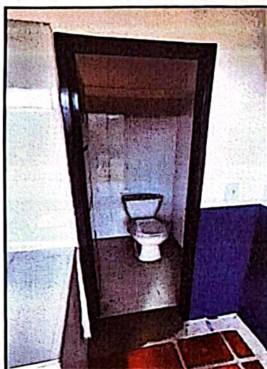
Ilustración 11 Bateria sanitaria intervenida
