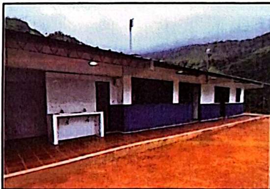
Ilustración 12 Fachada principal intervenida
