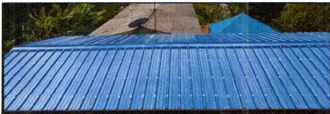
Ilustración 4 Cubierta termoacústica tipo sándwich
