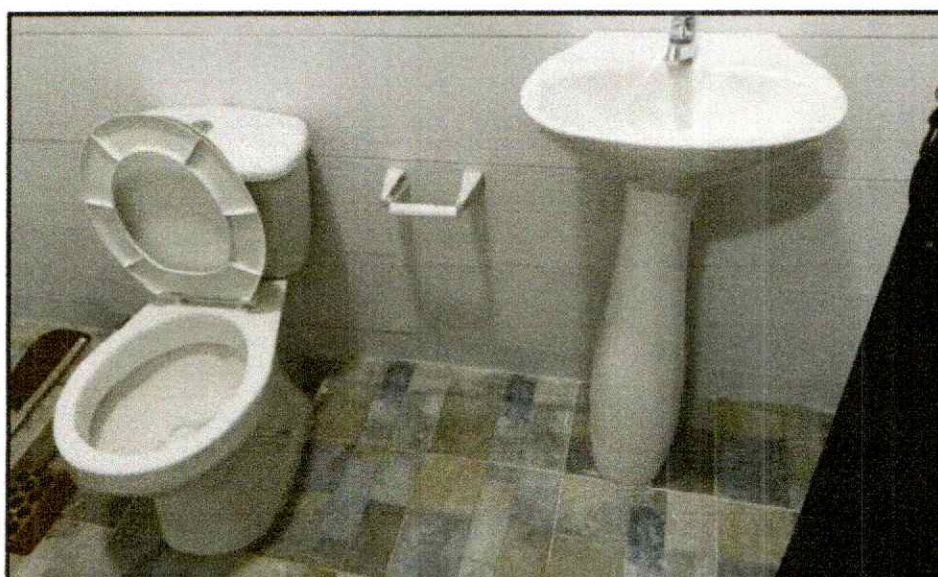
Ilustración 7 Bateria sanitaria de la habitación docente
