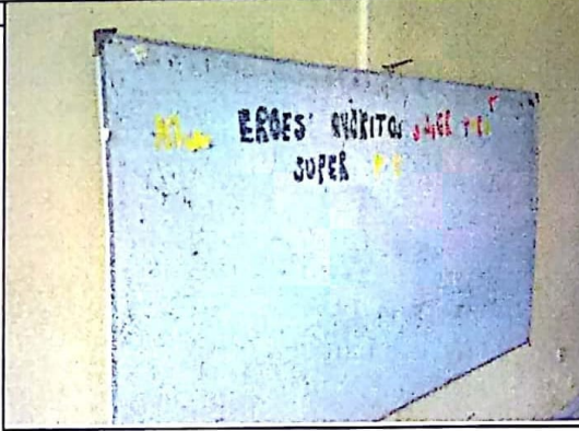
DETERIORO EN MOBILIARIOS (TABLEROS DE CLASES)
