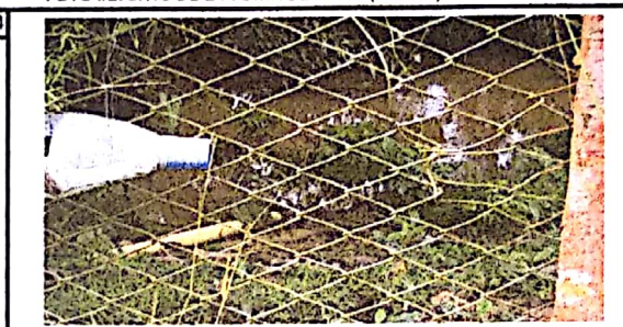
FOTO #4: SITIO DE DISPOSICION DE AGUAS SERVIDAS
