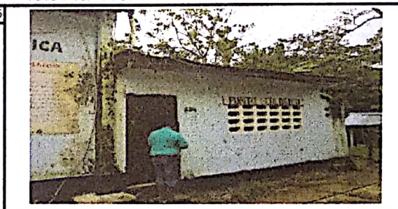
FOTO #6: ADECUACION DEL SALON DE LABORATORIO
