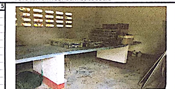
FOTO #5: MESON PARA DEMOLER LABORATORIO
