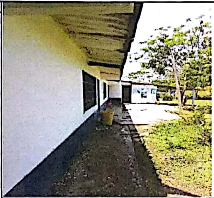
SE REQUIERE CANALES DE AGUAS LLUVIAS. A1, A2, A3.
