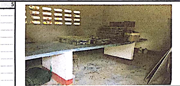
FOTO #5: MESON PARA DEMOLER LABORATORIO
