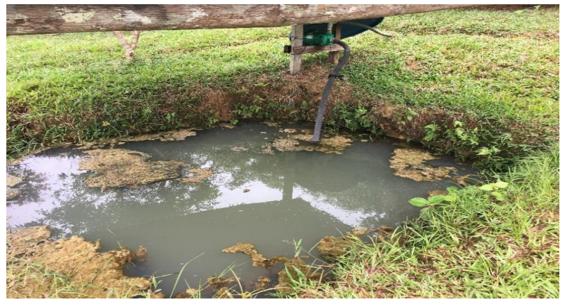
FOTO #2: TOMA DE AGUA DE LA IER ALJIBE CON ELECTROBOMBA
