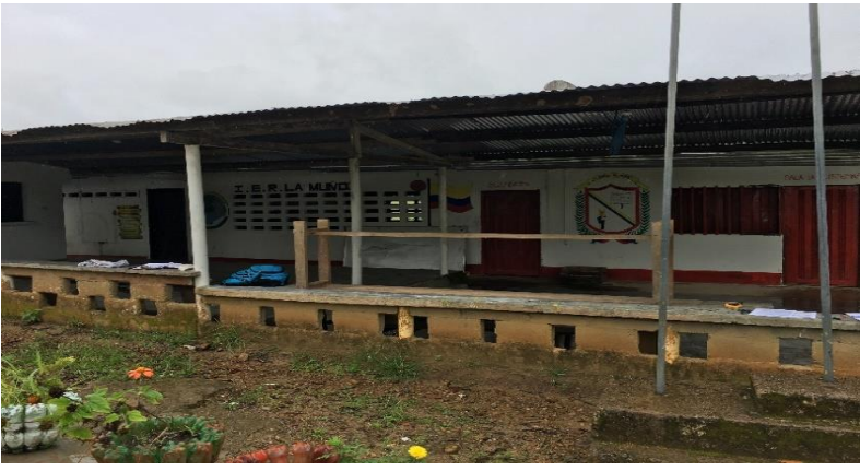
FOTO #1 SE OBSERVA LA FACHADA DE LA IER LA MUÑOZ
