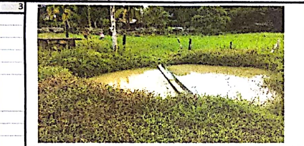
FOTO #3: TOMA DE AGUA ALIGBE DE 3X3
