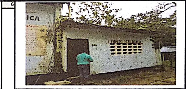
FOTO #6: ADECUACION DEL SALON DE LABORATORIO
