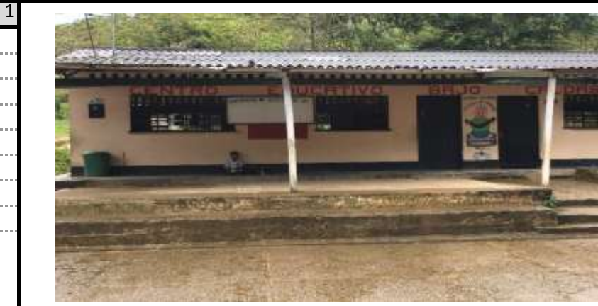
FOTO #1 SE OBSERVA LA FACHADA DE LA IER BAJO CALDAS
