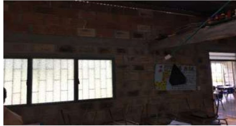
FOTO #4: ADECAACION DEL SALON DE PREESCOLAR BLOQUE 1
