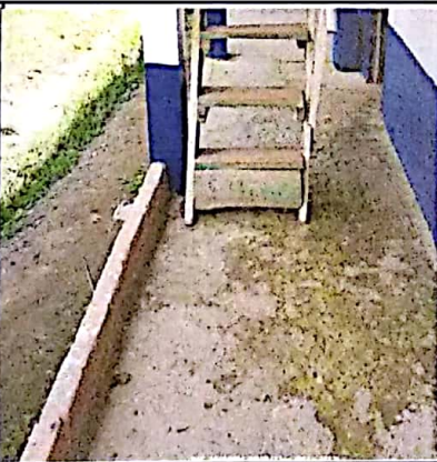
SE REQUIERE CANALES DE AGUAS LLUVIAS EN INTERNADO. ACTUALMENTE SE RETIENE EL AGUA CON LADRILLOS PROVISIONALES.
