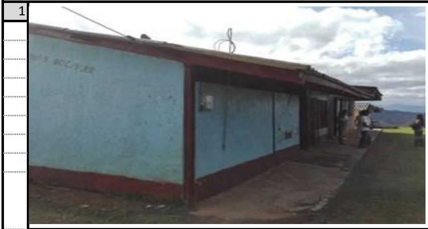
PINTURA MUROS AULA 1 Y REPOSICION ANDEN
