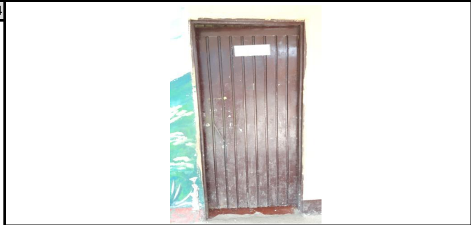
PUERTA ACCESO AULA 1
