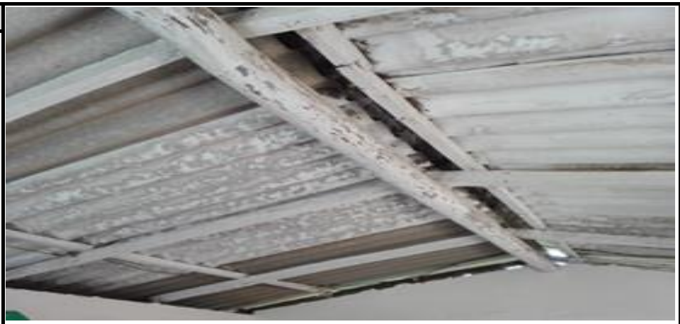
ESTRUCTURA CUBIERTA COCINA
