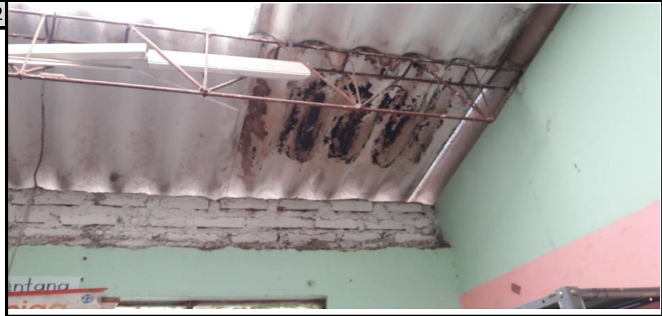
INTERIOR CUBIERTA AULA
