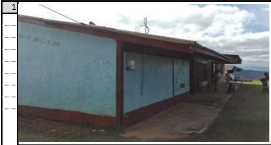
PINTURA MUROS AULA 1 Y REPOSICION ANDEN
