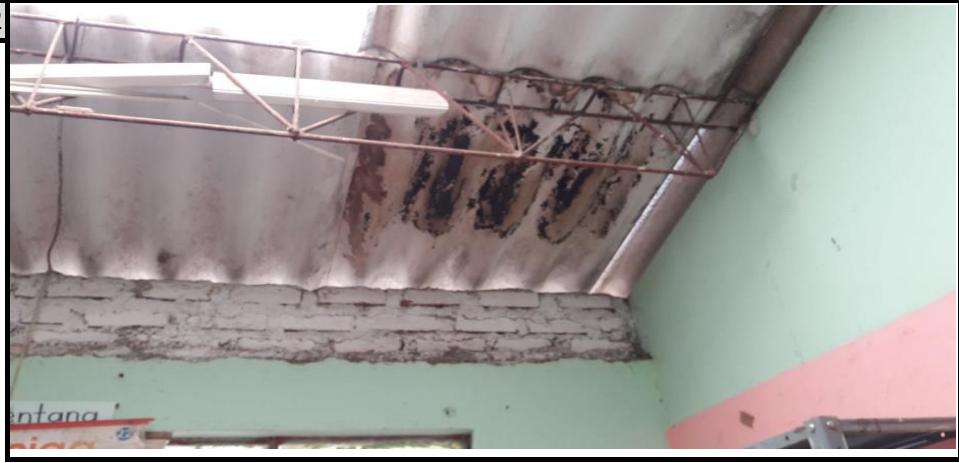
INTERIOR CUBIERTA AULA
