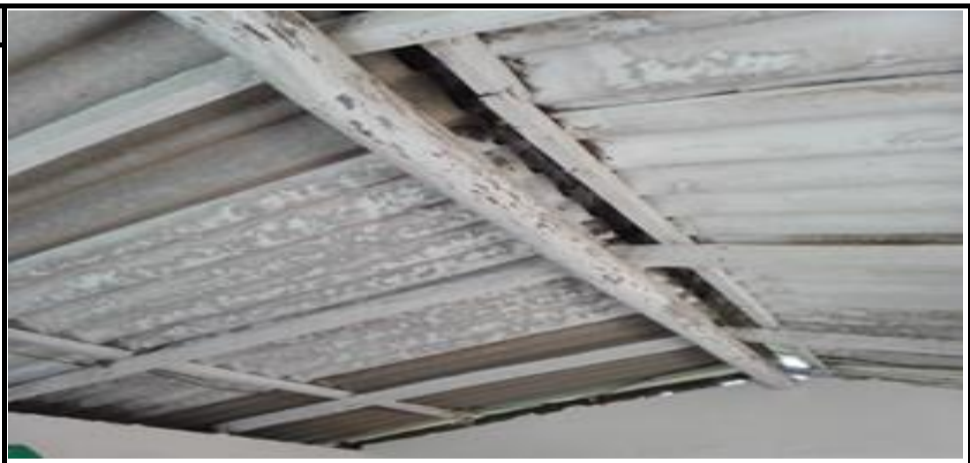
ESTRUCTURA CUBIERTA COCINA
