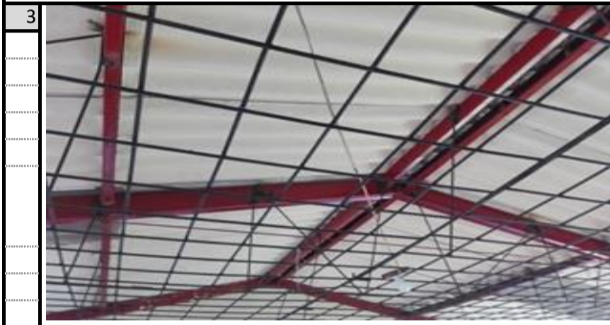
CIELO FALSO AULAS
