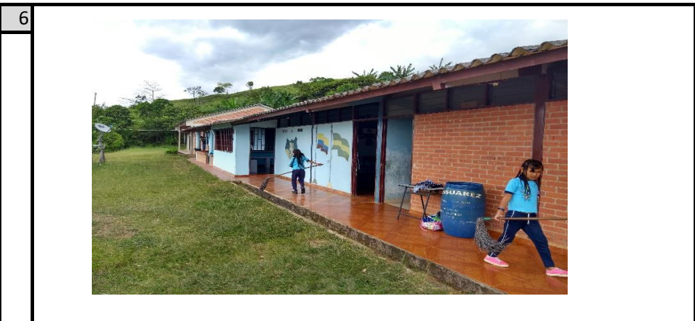
AULAS Y CORREDOR HACIA EL COMEDOR
