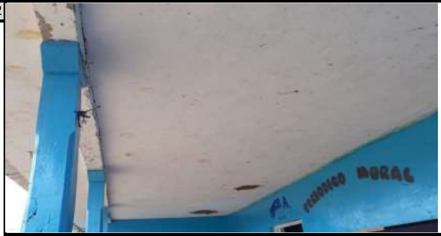
vista exterior del cielo raso en esterilla y bahareque
