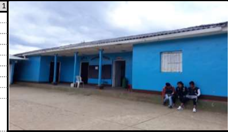
vista frontal bloque 1 a intervenir
