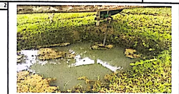
FOTO #2: TOMA DE AGUA DE LA IER ALGIVE CON ELECTROBOMBA
