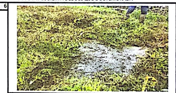
FOTO #6: AREA DEL POZO SEPTICO
