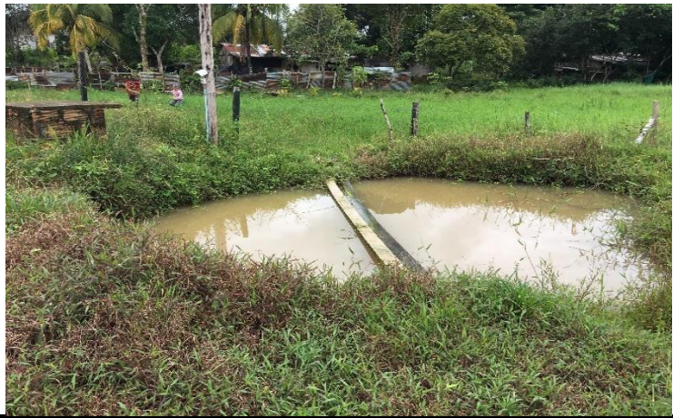
FOTO #3: TOMA DE AGUA ALJIBE DE 3X3
