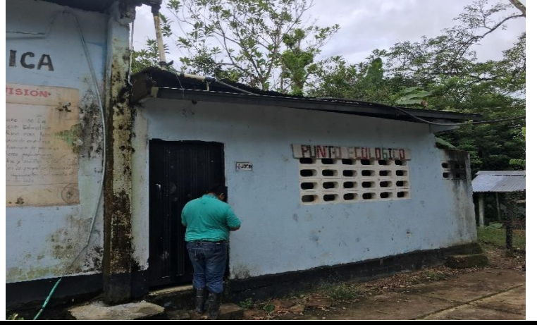
FOTO #6: ADECUACION DEL SALON DE LABORATORIO
