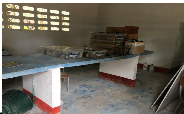
FOTO #5: MESON PARA DEMOLER LABORATORIO
