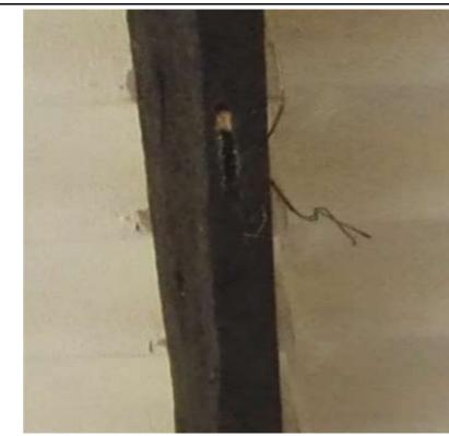
VIGA HUECA DEBIDO A LAS PLAGAS QUE ATACAN LA MADERA DE LA ESTRUCTURA DE CUBIERTA
