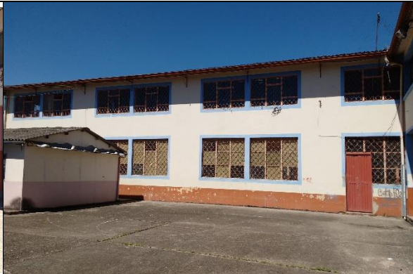
Fotografía 4. Vista frontal del bloque 3 – en proceso de demolición por la Gobernación de Boyacá
