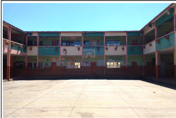
Fotografía 3. Vista posterior del bloque 3 – en proceso de demolición por la Gobernación de Boyacá
