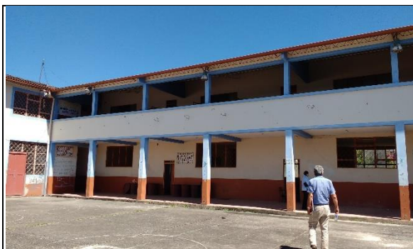
Fotografía 1. Vista lateral del bloque 1 – en proceso de demolición por la Gobernación de Boyacá
