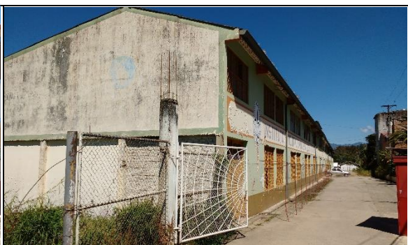
Fotografía 1. Vista frontal y lateral del bloque 1 – en proceso de demolición por la Gobernación de Boyacá
