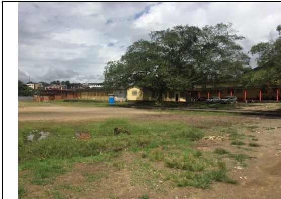
Fotografía 1. Estado actual Infraestructura Educativa.
