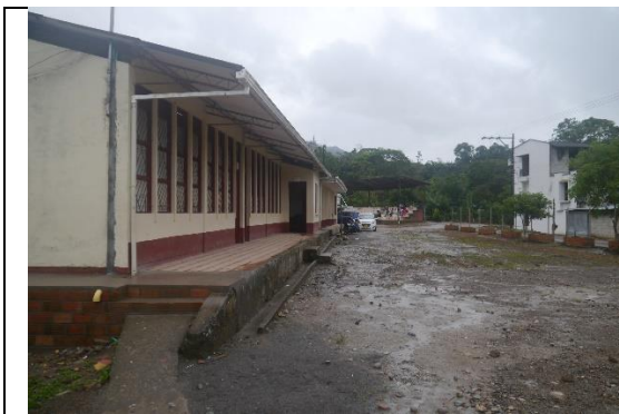
Fotografía 1. Estado actual Infraestructura Educativa.
