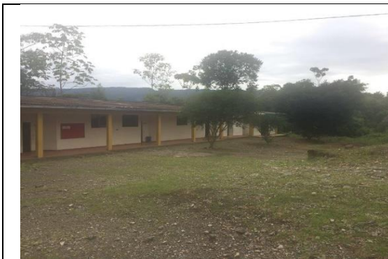
Fotografía 1. Estado actual Infraestructura Educativa.
