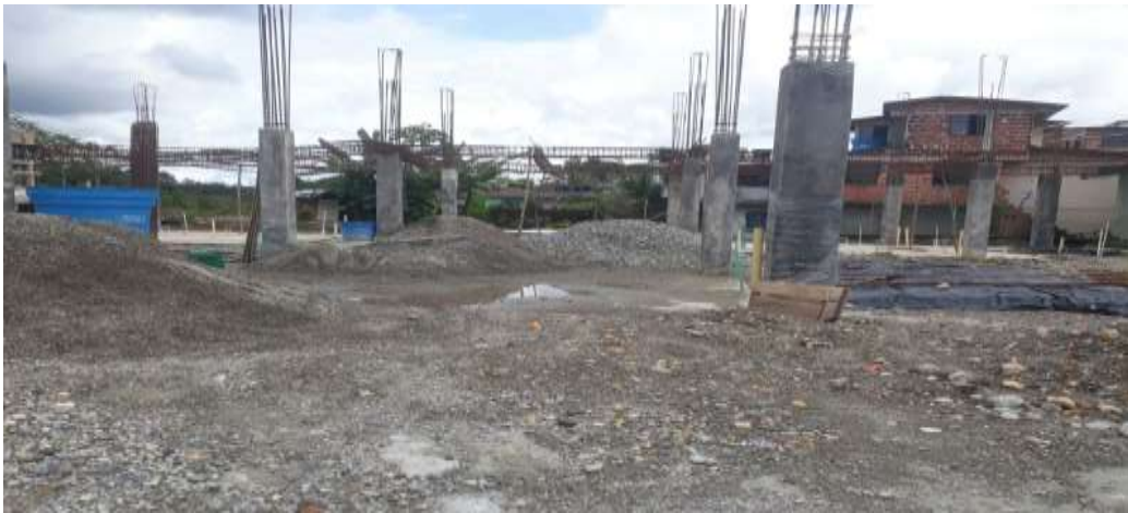
PANORAMICA ESTADO ACTUAL OBRA
