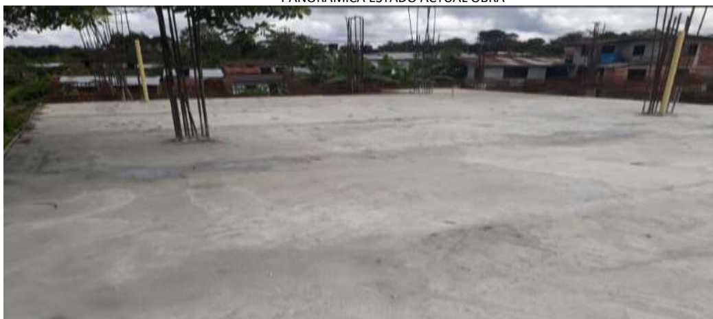
PANORAMICA ESTADO ACTUAL OBRA
