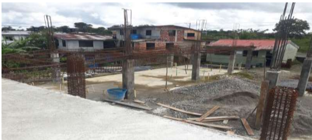
PANORAMICA ESTADO ACTUAL OBRA
