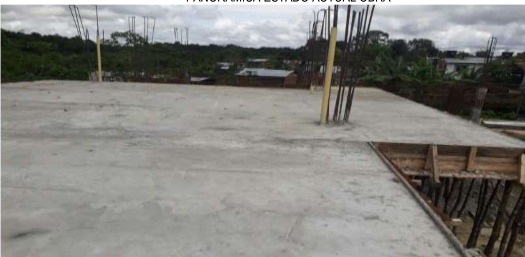
PANORAMICA ESTADO ACTUAL OBRA
