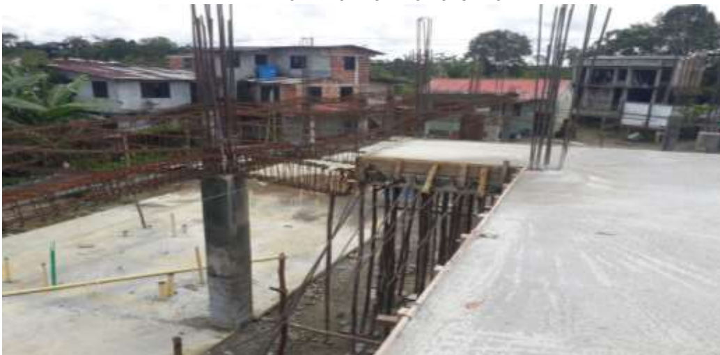
PANORAMICA ESTADO ACTUAL OBRA
