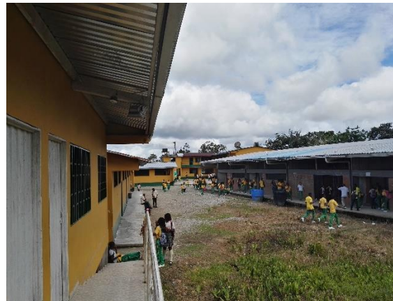
Fotografía 2. Estado actual Infraestructura Educativa
