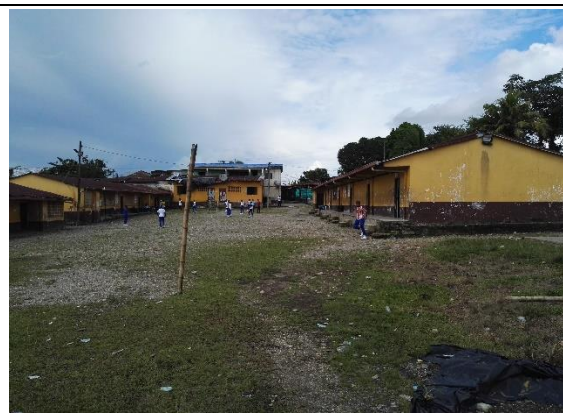
Fotografía 2. Estado actual Infraestructura Educativa
