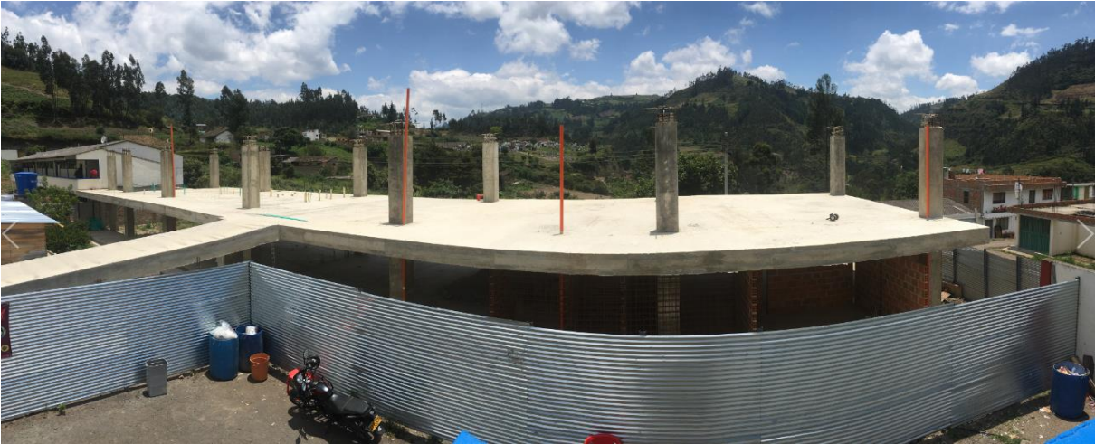
PANORAMICA ESTADO ACTUAL OBRA
