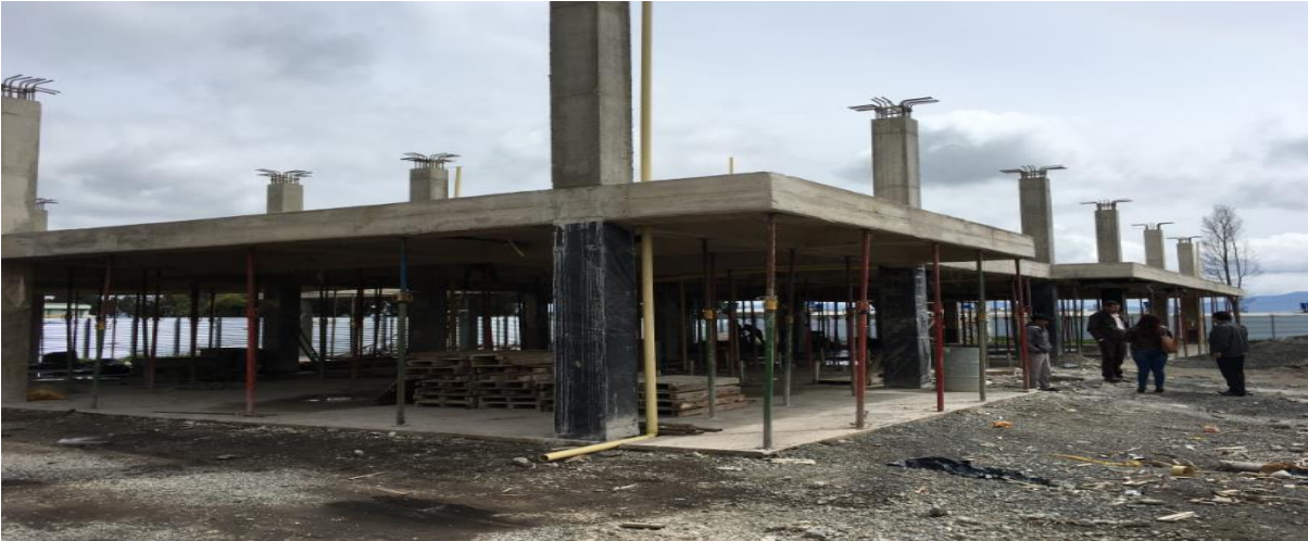
PANORAMICA ESTADO ACTUAL OBRA
