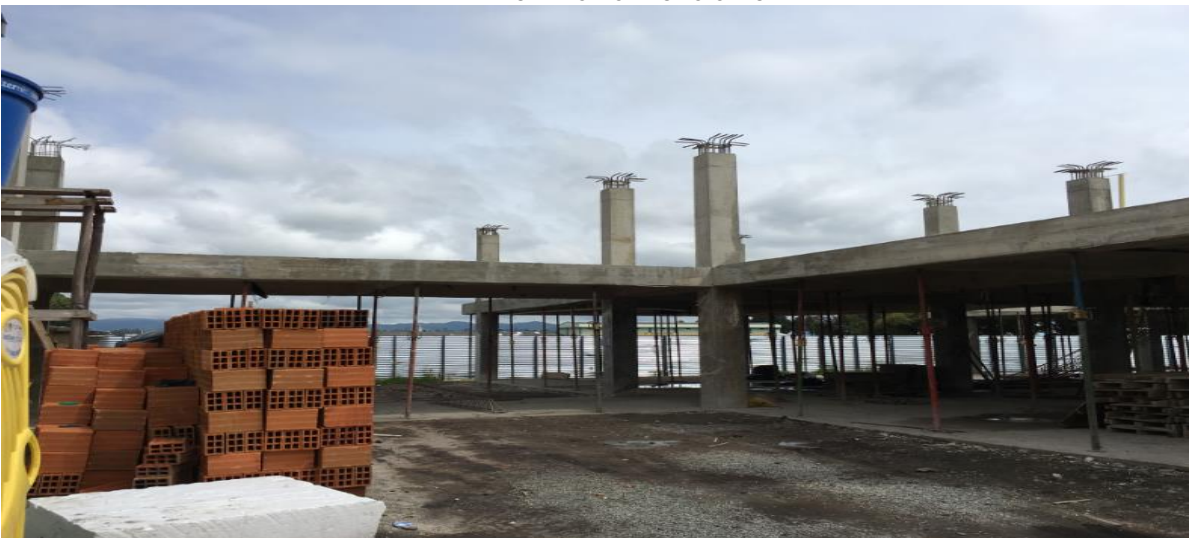
PANORAMICA ESTADO ACTUAL OBRA
