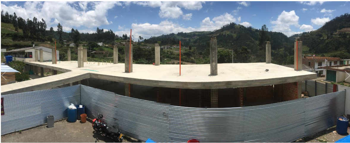
PANORAMICA ESTADO ACTUAL OBRA
