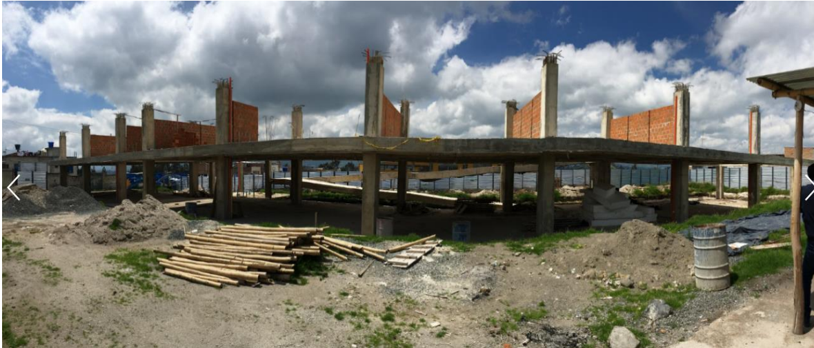
PANORAMICA ESTADO ACTUAL OBRA
