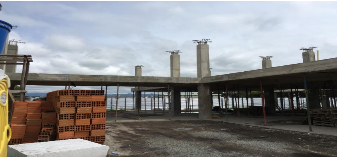
PANORAMICA ESTADO ACTUAL OBRA
