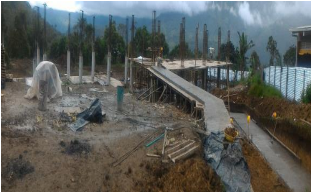
PANORAMICA ESTADO ACTUAL OBRA
