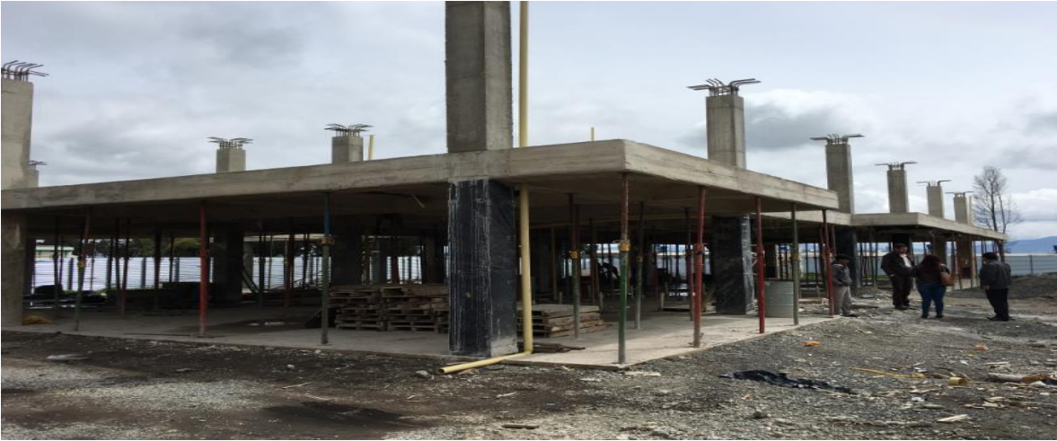
PANORAMICA ESTADO ACTUAL OBRA
