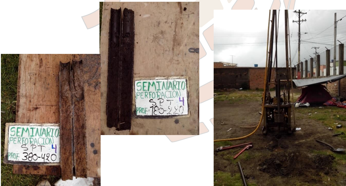
Fotografías 12 a 14. Exploraciones de campo y estratigrafía Perforación P-4
