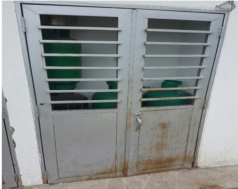
Foto 5. Deposito de gas GLP
