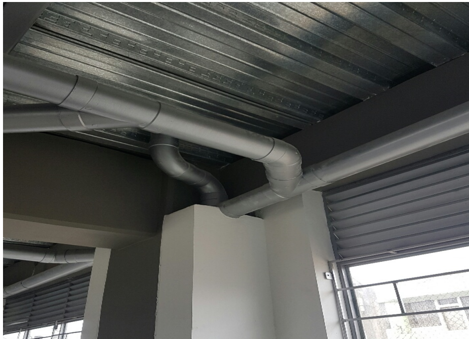
Foto 3. Bajante de aguas negras con tubería a la vista
