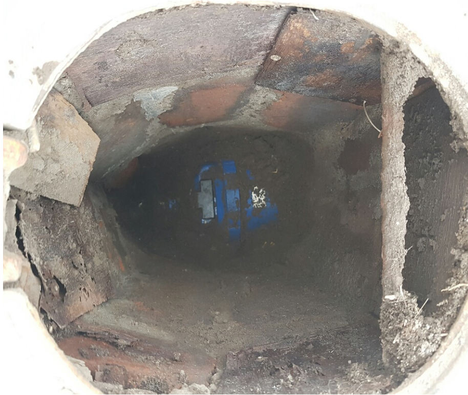
Foto 1. Macromedidor de piso 2".
