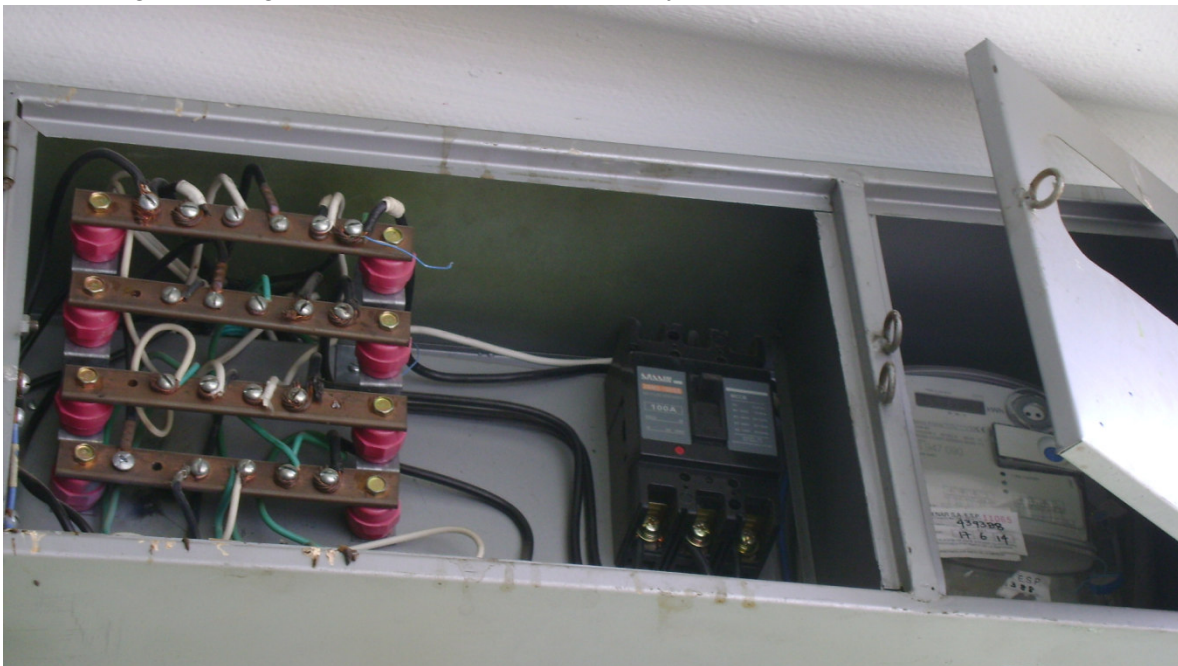
IMAGEN 1 TABLERO PRINCIPAL. TRIFÁSICO UBICACIÓN MURO ENTRADA PRINCIPAL.
