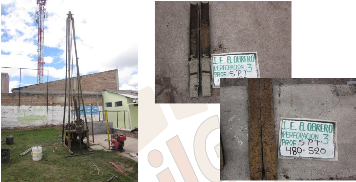
Fotografías 9 a 11. Exploraciones de campo y estratigrafía Perforación P-3
