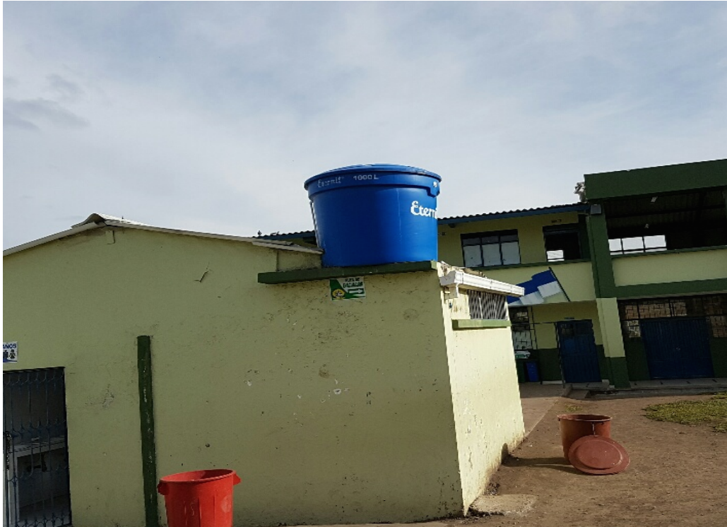
Foto 2. Tanque Elevado de 500 litros
