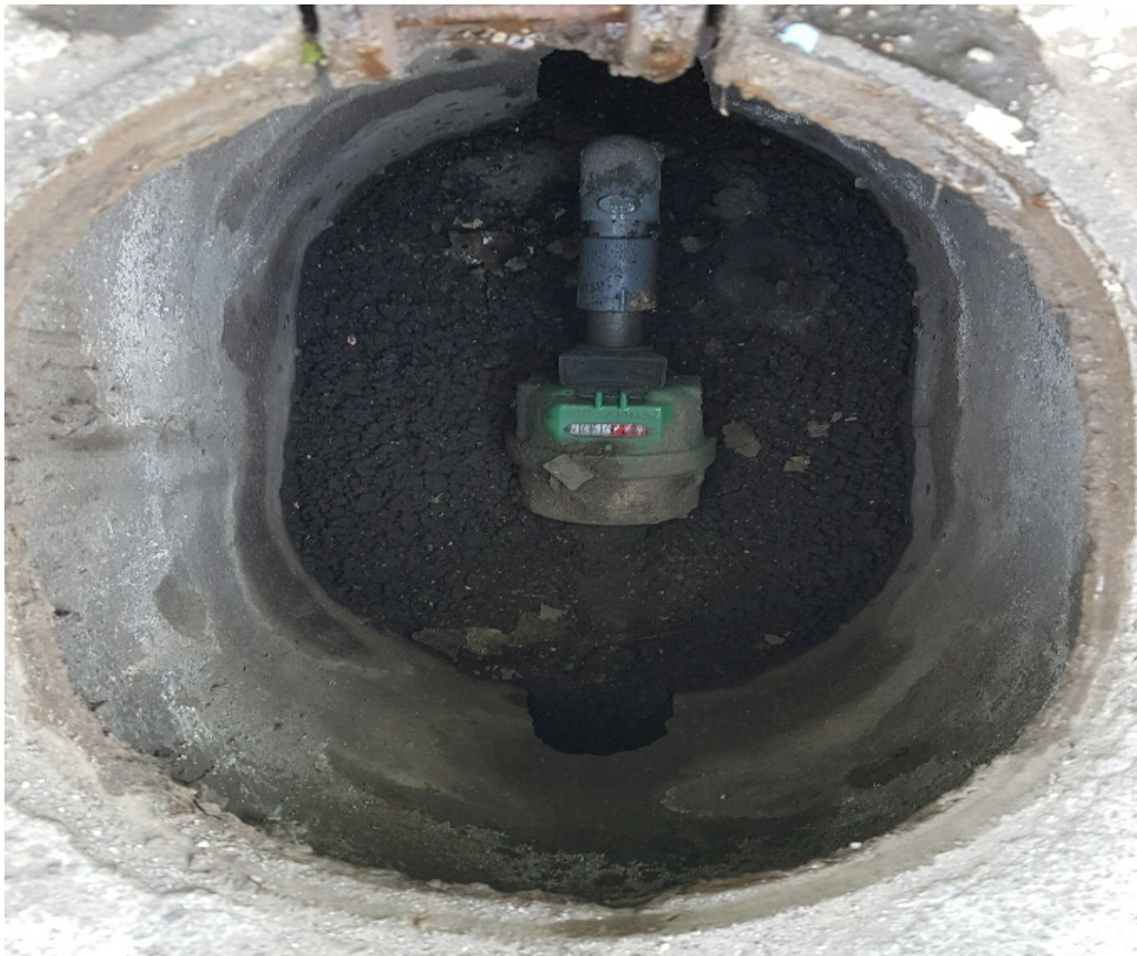
Foto 1. Medidor existente en piso sobre andén Calle 17 A de ½"
