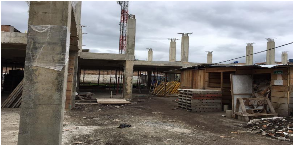
PANORAMICA ESTADO ACTUAL OBRA
