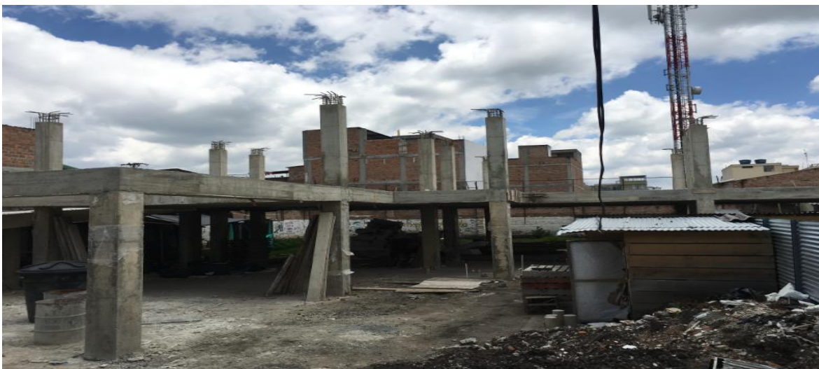
PANORAMICA ESTADO ACTUAL OBRA
