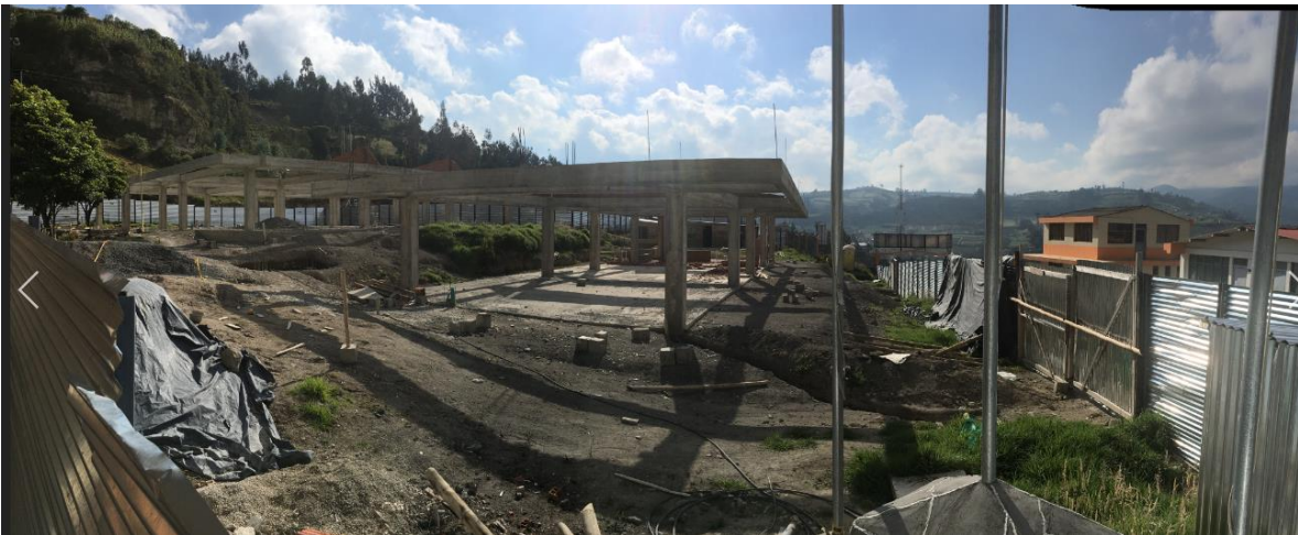
PANORAMICA ESTADO ACTUAL OBRA
