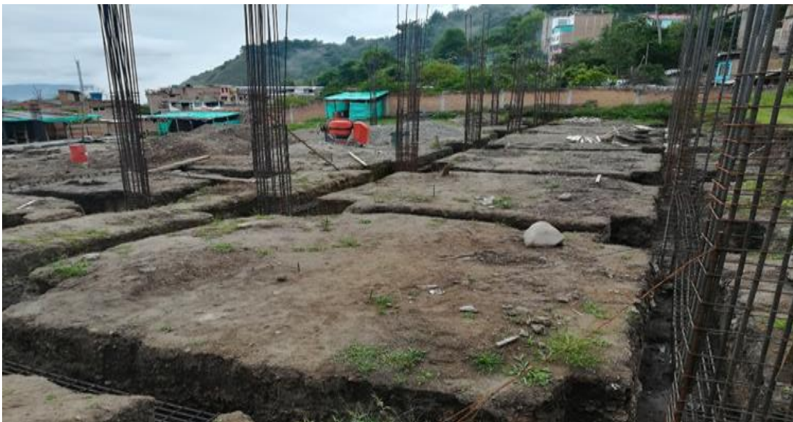
PANORAMICA ESTADO ACTUAL OBRA
