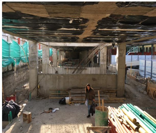
ESTADO ACTUAL OBRA
