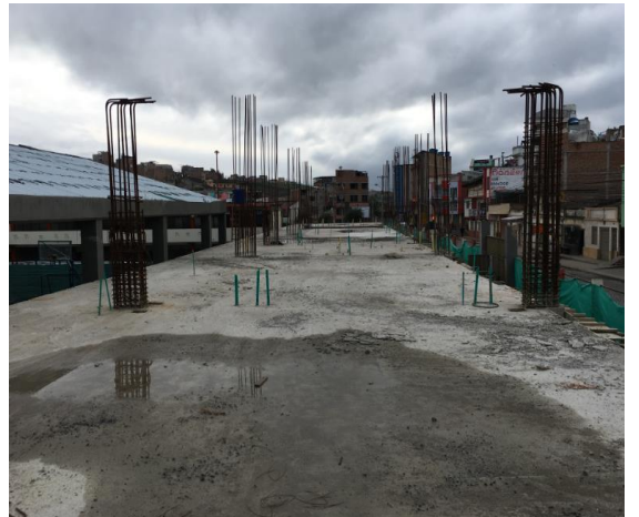
ESTADO ACTUAL OBRA
