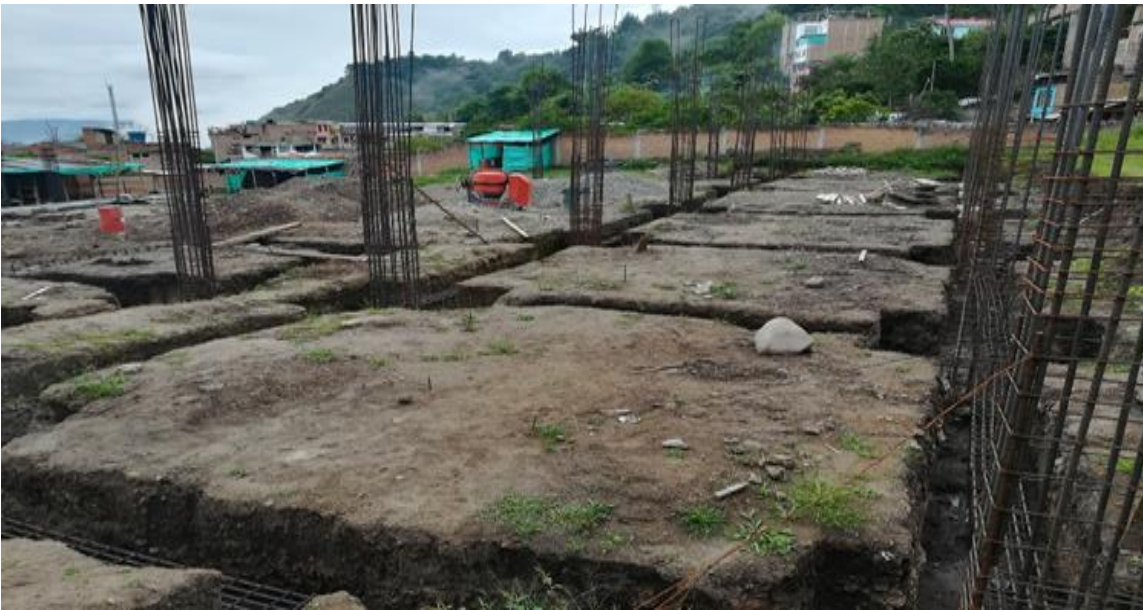
PANORAMICA ESTADO ACTUAL OBRA
