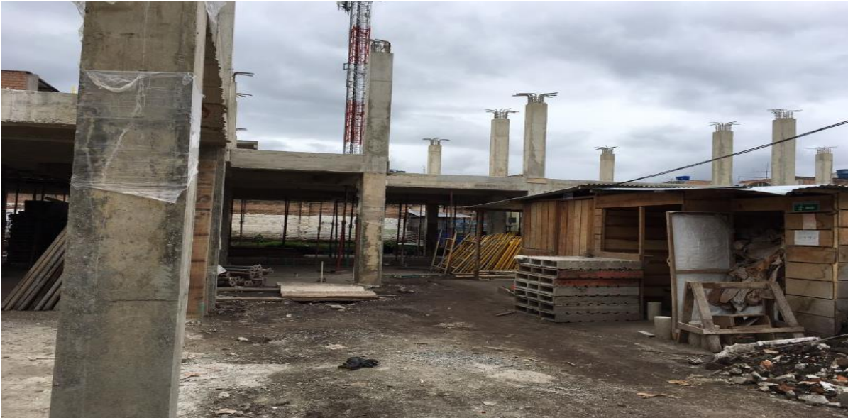
PANORAMICA ESTADO ACTUAL OBRA
