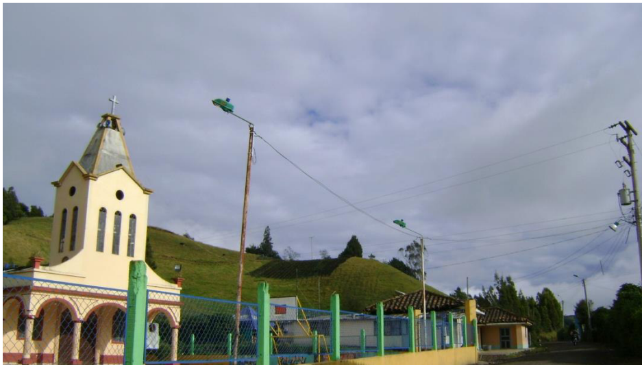
Al fondo se puede apreciar la estructura correspondiente al transformador.
