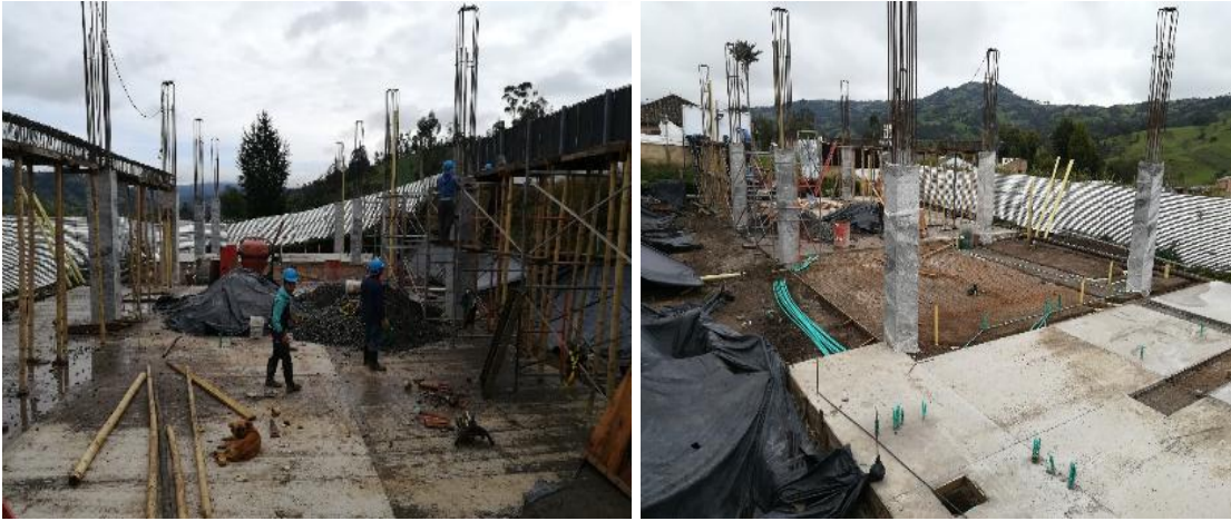
PANORAMICA ESTADO ACTUAL OBRA
