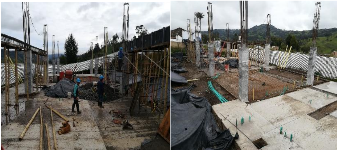
PANORAMICA ESTADO ACTUAL OBRA
