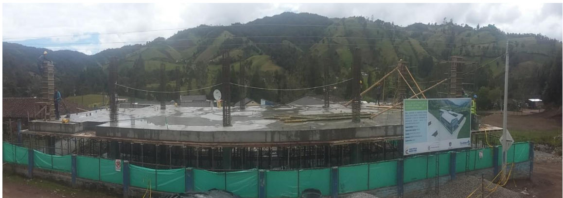
PANORAMICA ESTADO ACTUAL OBRA
