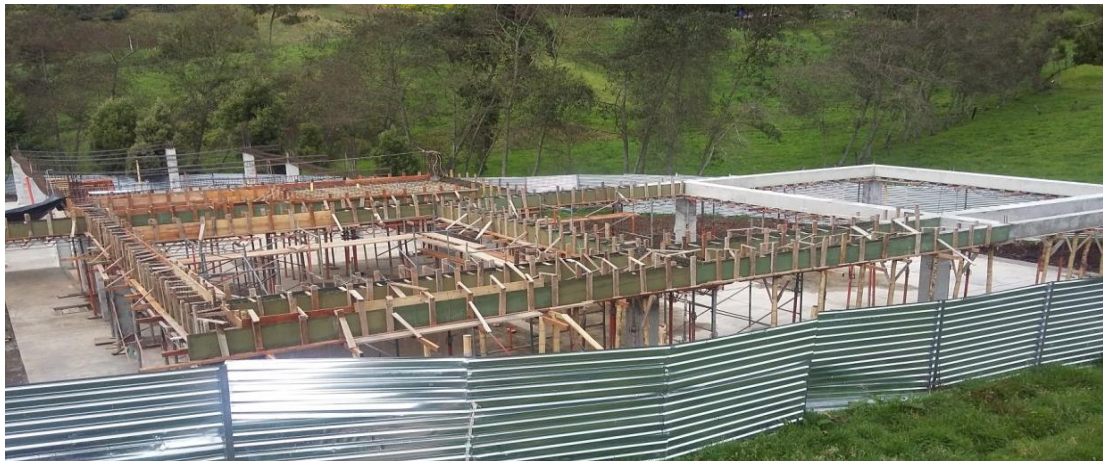
PANORAMICA ESTADO ACTUAL OBRA
