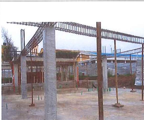
FOTO 9. MODULO 1, ACERO DE VIGAS AEREAS, TUBERIA SALIDAS ELECTRICAS, SALIDAS SANITARIAS DE LABORATORIO
