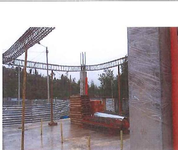
FOTO 10. MODULO 1, ACERO DE VIGAS AEREAS, SALIDAS SANITARIAS ZONA DE COCINA
