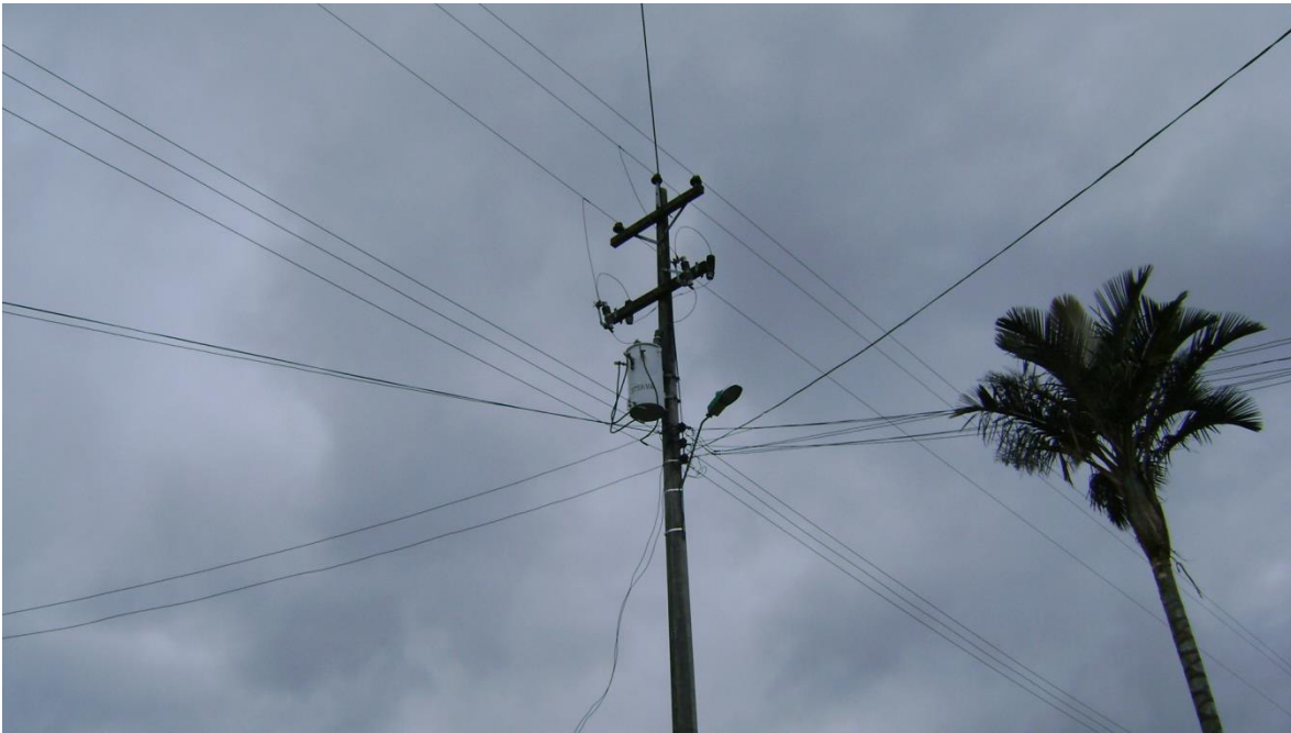
TRANSFORMADOR 37.5 KVA
