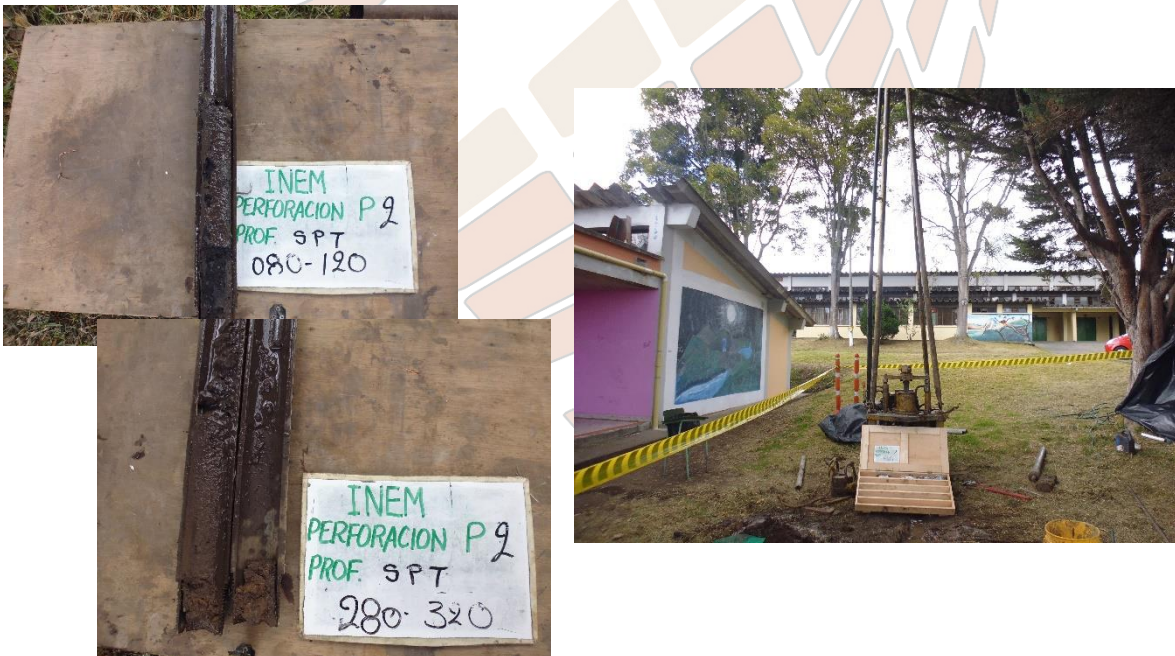
Fotografías 6 a 8. Exploraciones de campo y estratigrafía Perforación P-2
