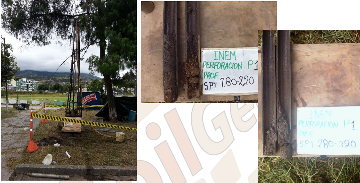
Fotografías 3 a 5. Exploraciones de campo y estratigrafía Perforación P-1
