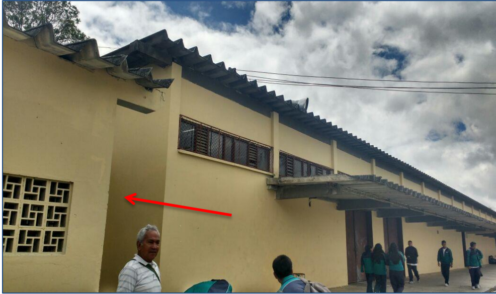
INGRESO A SUBESTACION
