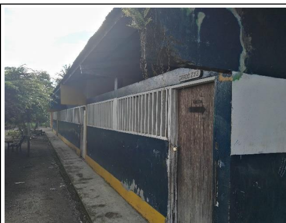
Fotografía 2. Estado actual Infraestructura Educativa
