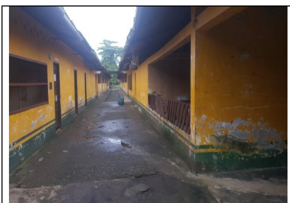
Fotografía 1. Estado actual Infraestructura Educativa.
