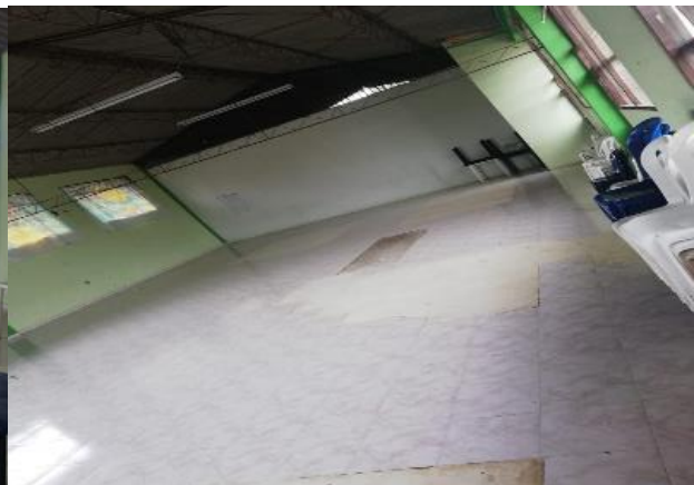
Fotografía 6. Aula Múltiple Existente
