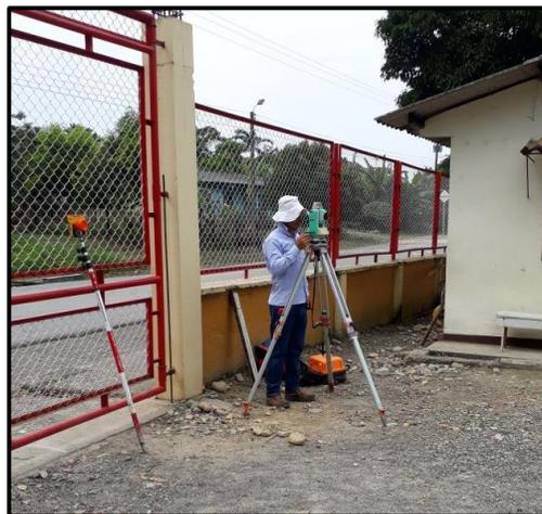
**Figura 15.** Poligonal cerrada con estación total
