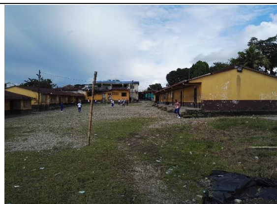
Fotografía 2. Estado actual Infraestructura Educativa
