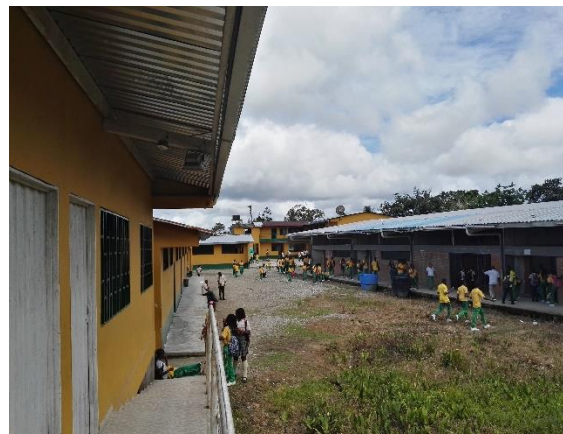
Fotografía 2. Estado actual Infraestructura Educativa
